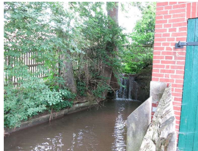
Mühlenwehr in Krückeberg
