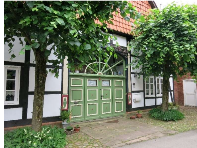
Fachwerkhaus in Zersen
