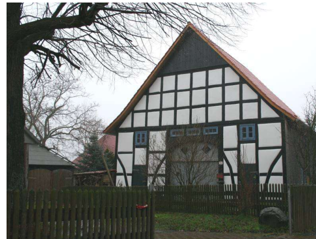
Fachwerkhaus in Wickbolsen 3
